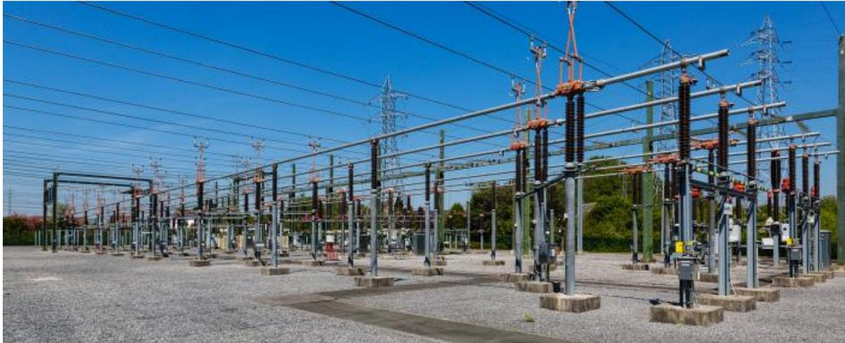
Figure 1.4 : sous-station 150 kV de type AIS
