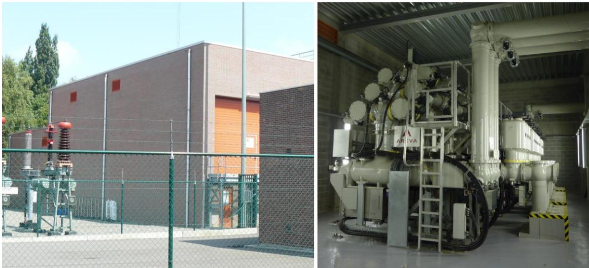
Figure 1.5 : sous-station 150 kV de type GIS
