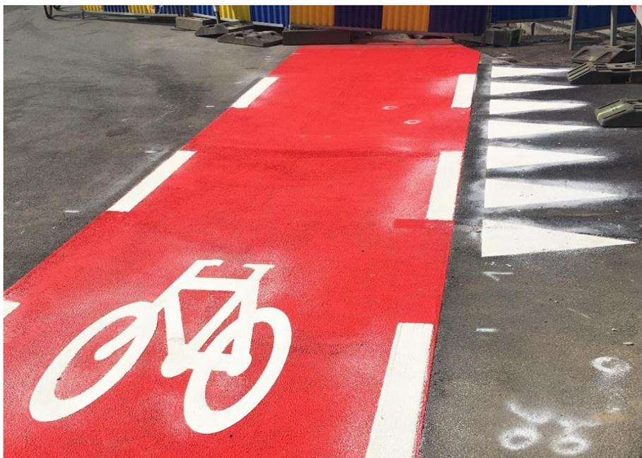
Figure 1.9 : réfection d’une piste cyclable suite à la pose d’un câble
