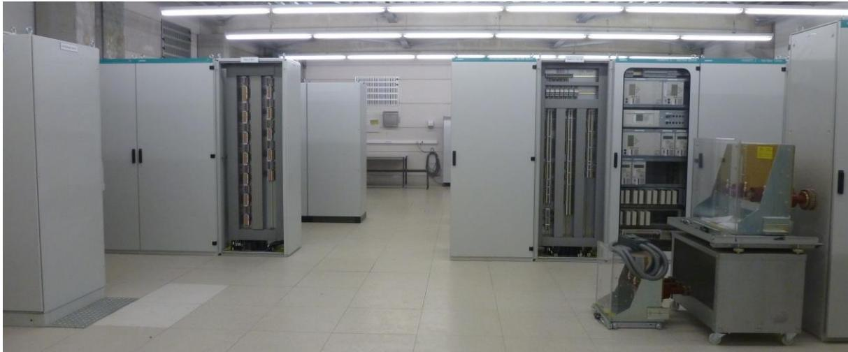
Figure 1.6 : équipements secondaires d'une sous-station
