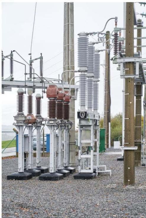
Figure 2.3 Premier disjoncteur sans SF6 d'une nouvelle génération sur le réseau 70kV d'Elia (sous-station 70kV de Marcourt)
