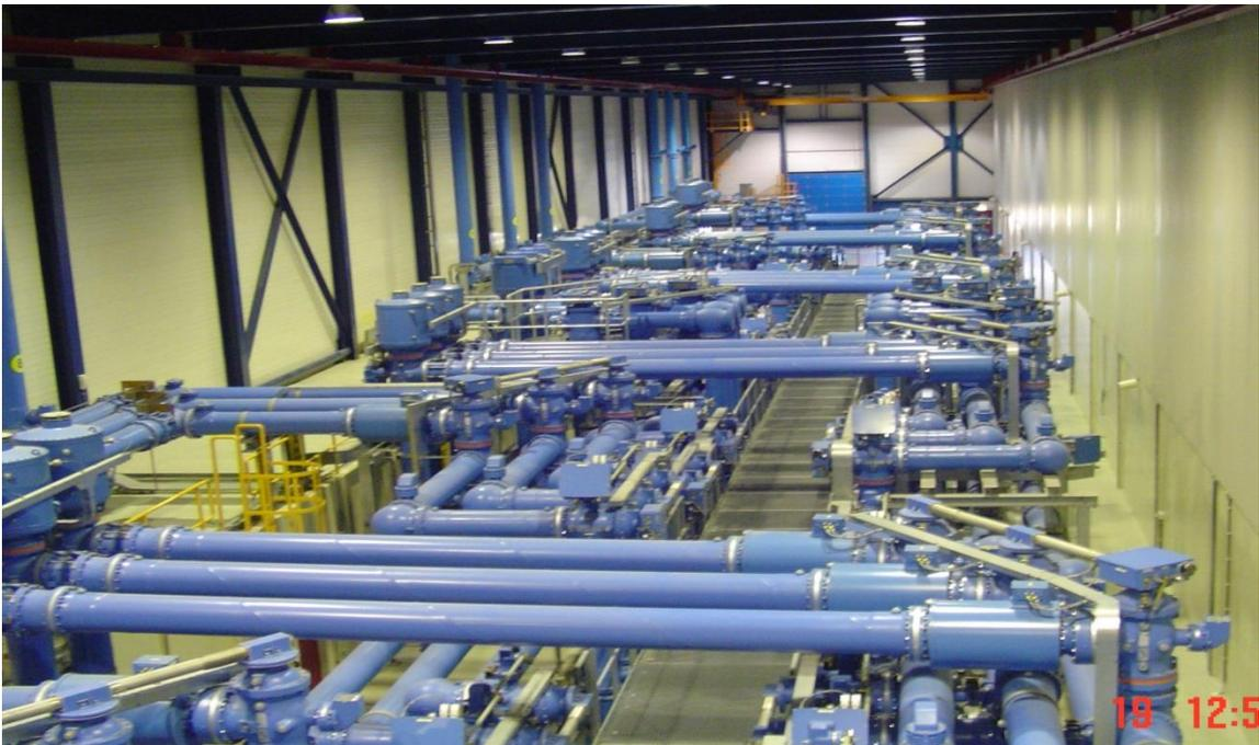
Photo 3 : Champs 380 kV dans une configuration GIS
