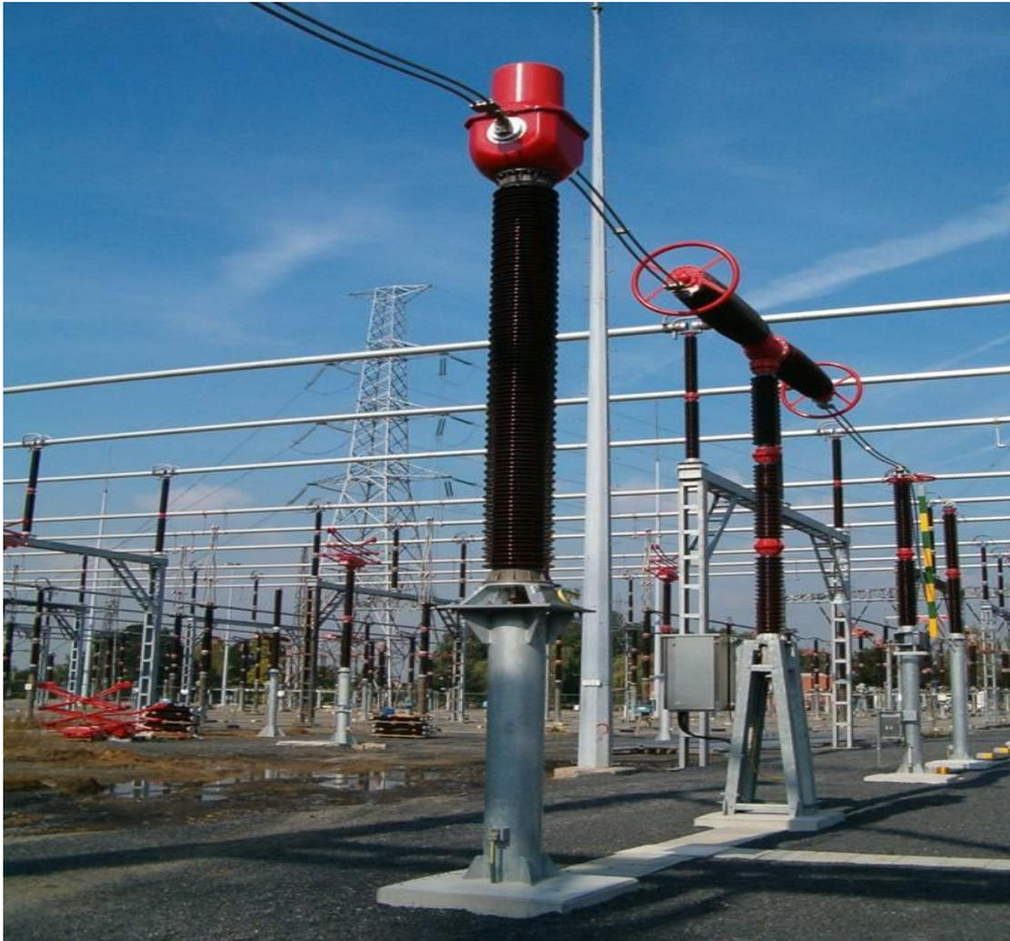
Photo 6 : Transformateur de courant avec un disjoncteur en arrière-plan
