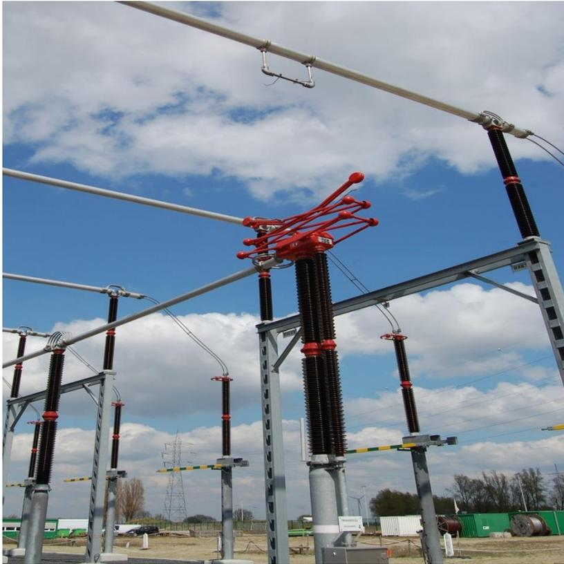
Photo 4 : Sectionneur d'aiguillage, type pantographe avec mise à la terre (vert-jaune) en arrière-plan.
