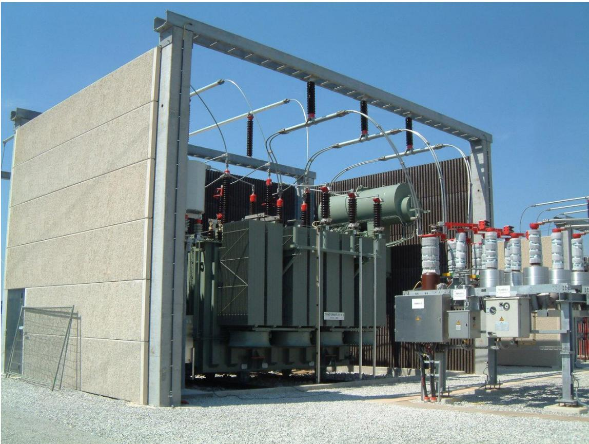
Photo 1 : Vue d'un transformateur de puissance 380/150 kV installé au-dessus d'un bac de récupération en béton et entouré de murs sonores.
