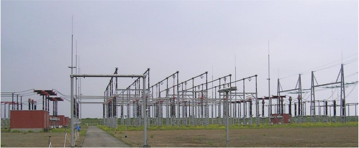
Photo 2 : Champs de 380 kV dans une installation à l'air libre (AIS)
